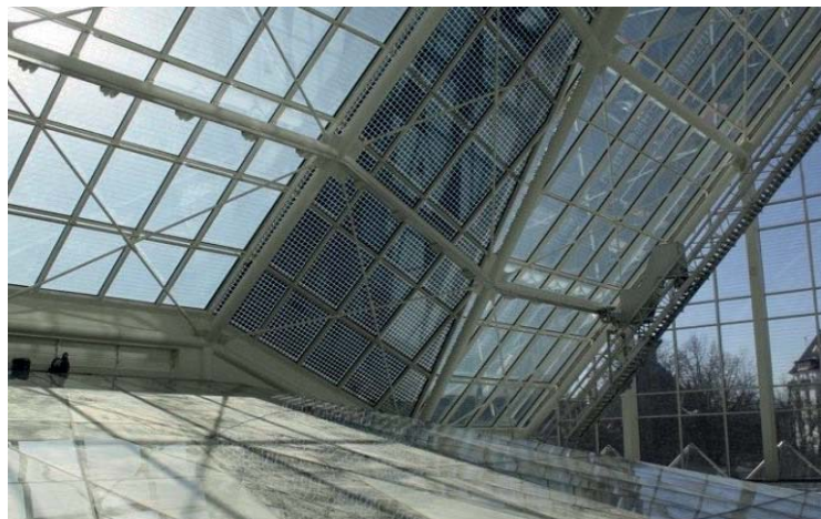
MICRO SHADE zamontowany na dachu budynku
