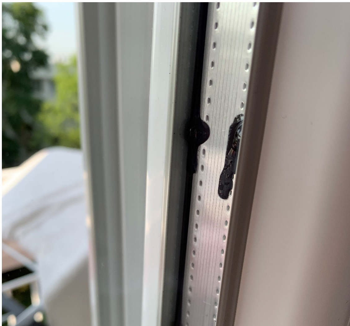
Rys 21 Efekt zastosowania niekompatybilnych materiałów.
